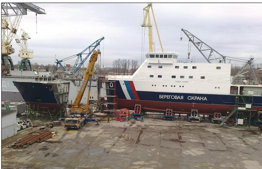
Патрульное судно пр. 22120 (зав. № 050). Стыковка носового блока с основным корпусом
